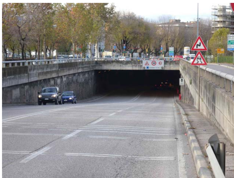
Figura 19: imbocco del sottopasso di Porta Palio: si notano i diaframmi laterali di sostegno non rivestiti e lasciati a vista, il marciapiede laterale di servizio su entrambi i lati, la tipologia di parapetto realizzata con un muro in c.a. sovrastato da un tubo metallico pesante
