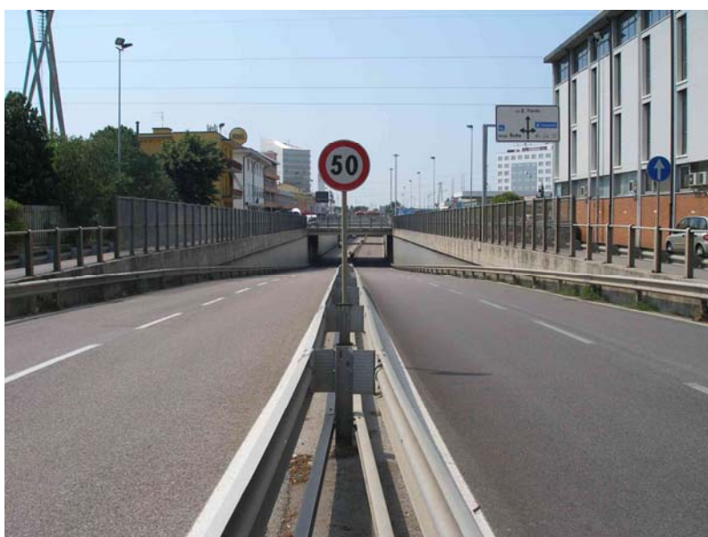
Foto 7: Viale delle Nazioni visto verso sud in corrispondenza dell'inizio della trincea del sottopasso
