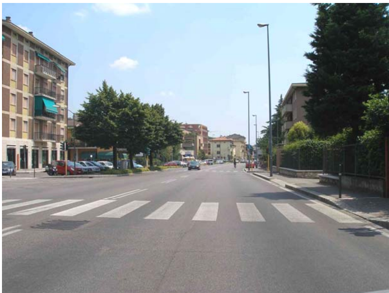
Foto 2: un tratto di via Mameli nel quale si notano un impianto semaforico, più attraversamenti pedonali, i marciapiedi laterali ed un'area (limitata da aiuola) per la sosta dei veicoli in corrispondenza di attività commerciali
